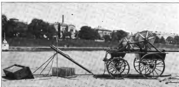
Abb. 152. Raketenapparat der Deutschen Gesellschaft zur Rettung Schiffbrüchiger.
